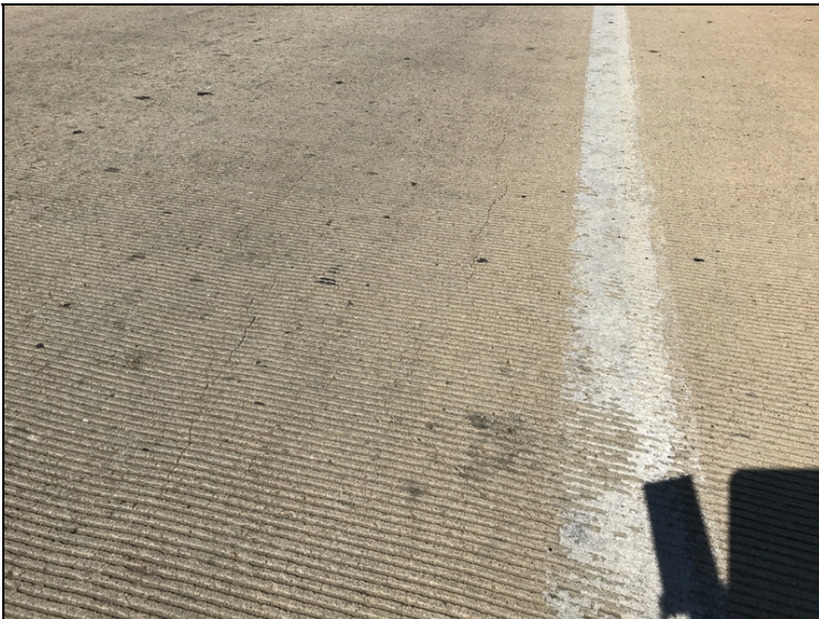
Typ longitudinal cracks
